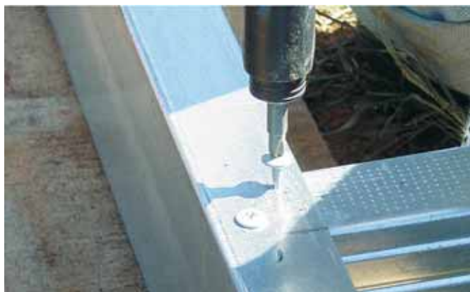
Figura 6 – União entre perfis de LSF
